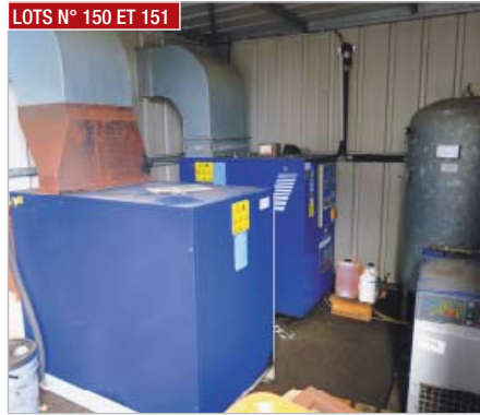
▶ Compresseurs MAUGUIERE , modèle MAV 250/A (2006), puissance 18 kW, pression de service 8 bars ▶ MAUGUIERE compressors, model MAV 250/A, (2006), power 18 kW, duty pressure 8 bars
